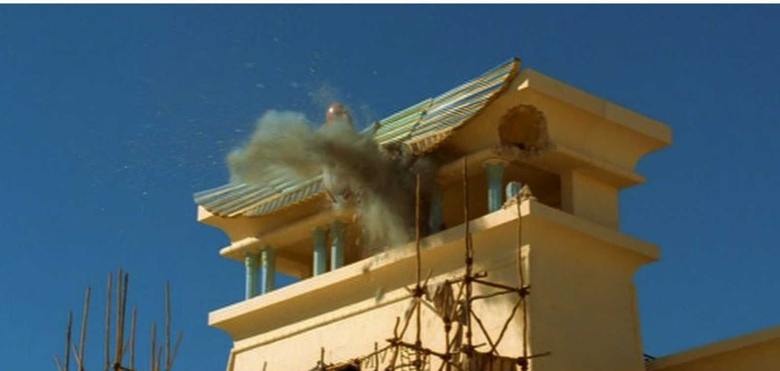
Mission Cléopâtre : contre les structures des bâtiments en construction.
